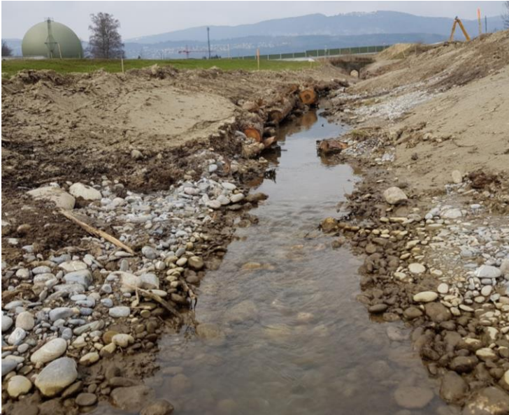
Renaturierung Orpundbach, Ausführung April 2018
